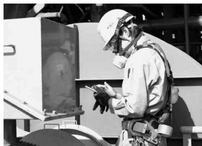
タブレット端末を現場で点検しながら入力するなど、クラウドへの移行で現場作業の効率化を実現
